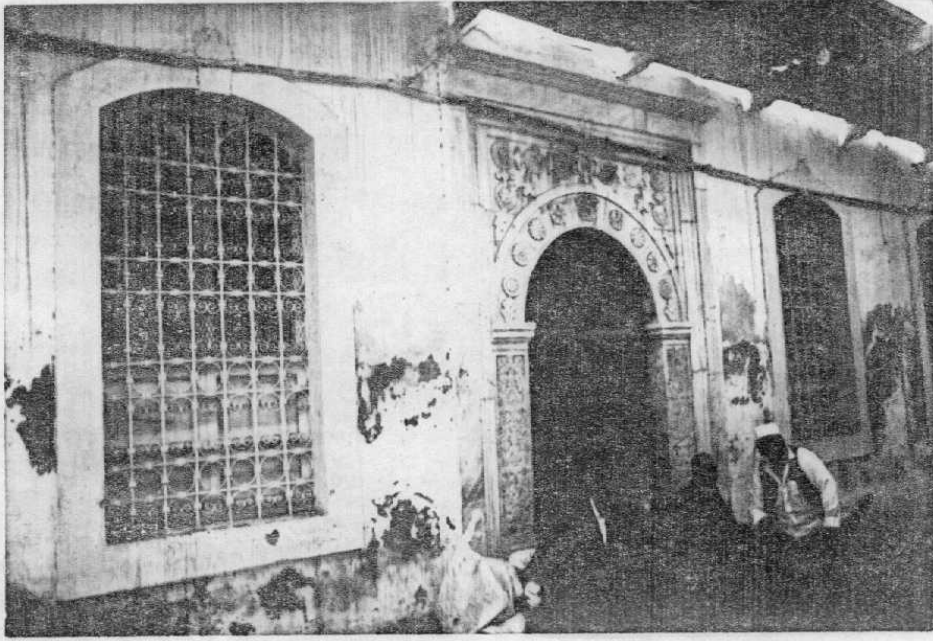
لوحة (٢٢) الواجهة الرئيسية (الجنوبية الغربية) لجامع شائب العين ويظهر فيها نموذج لفتحات النوافذ المعقودة بعقود قوسية كما تظهر نماذج للمشبكات التي تغشى فتحات النوافذ .
