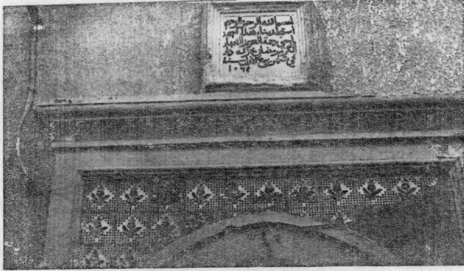
لوحة (٦٢) اللوحة التأسيسية لمسجد النخلى سنة ١٠٦٤هـ على يد رمضان خازندار وتظهر البلاطات التي تغطي كوشتي عقد المدخل
